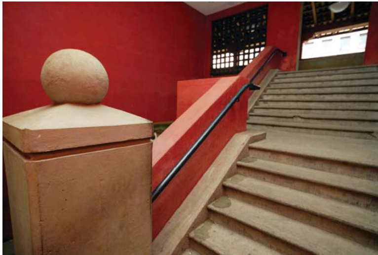
Detalle de las escaleras interiores que conducen al segundo piso del edificio del Ministerio de Relaciones Exteriores.
