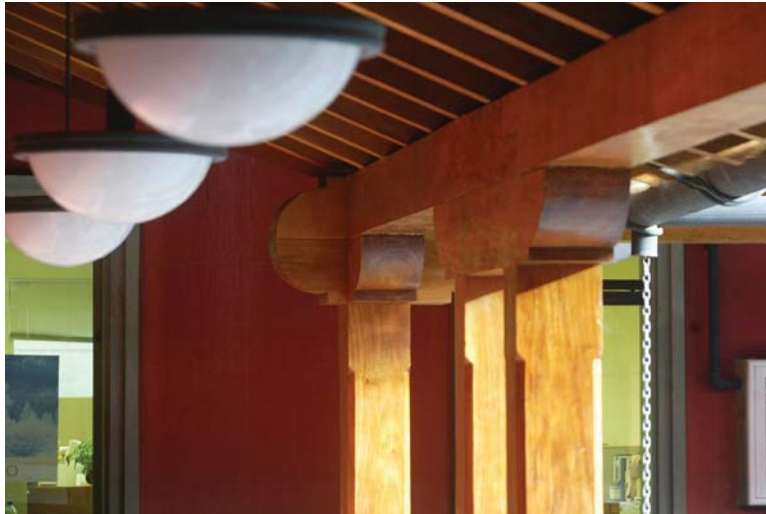
Detalle del techo del segundo piso del Ministerio de Relaciones Exteriores.
