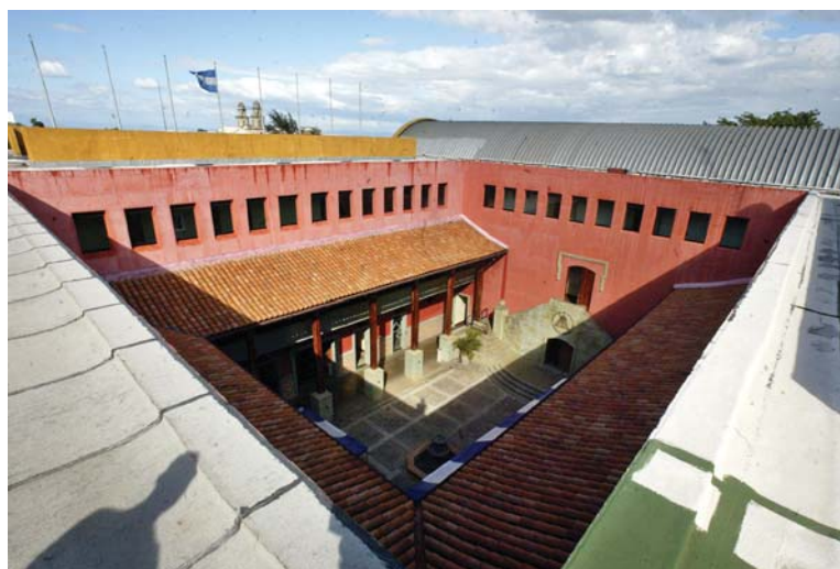
Vista general del edificio de Cancillería desde de la parte superior del techo. Al fondo a la izquierda se observan las torres de la antigua Catedral de Managua.
